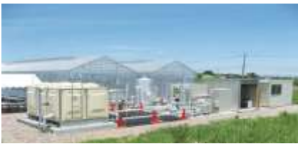
西川浄化センター
