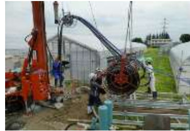
地中熱交換器の設置工事
