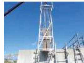
下水処理水路での熱交換器設置工事
