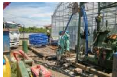
地中熱交換器の設置工事
