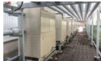
地下水(井水)利用の地中熱ヒートポンプ
