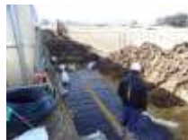
シート型熱交換器設置（深さ1m）
